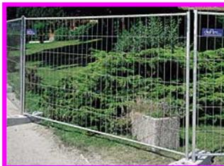
Ai pannelli in rete elettrosaldata andranno sovrapposte, di modo che siano opportunamente tese, reti colorate in rosso o arancione e/o teli antipolvere in funzione della posizione di lavoro. Tutti i sistemi portanti dovranno essere convenientemente controventati ad evitarne il ribaltamento per il passaggio dei mezzi ed in caso di eventi meteo sfavorevoli.
