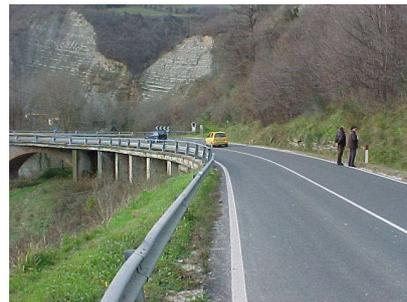
La controcurva e la scarpata di monte impediscono la visibilità e inoltre l'innesto quasi a gomito sul ponte Lamone tende a portare fuori traiettoria i veicoli. Questa situazione determina un elevato rischio di incidente e limita notevolmente la velocità di percorrenza in sicurezza di questo tratto di strada. A questo si aggiunge il fatto che la larghezza della piattaforma stradale è di soli 6.00 m.
